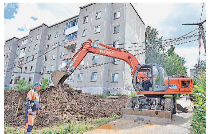
Ремонтные работы на пересечении улиц Лесной и Урицкого.
