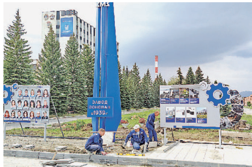
Работники цеха № 299 на реконструкции заводской стелы.
